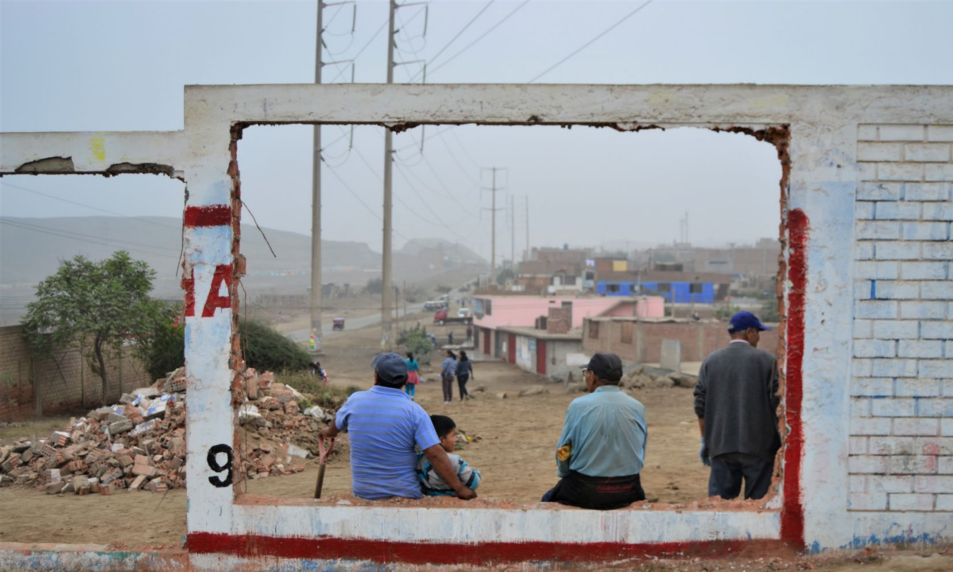
Javier Vera Cubas: Parque de la Integración. Demolición. Archivo CCC. Cortesía: Javier Vera Cubas.
