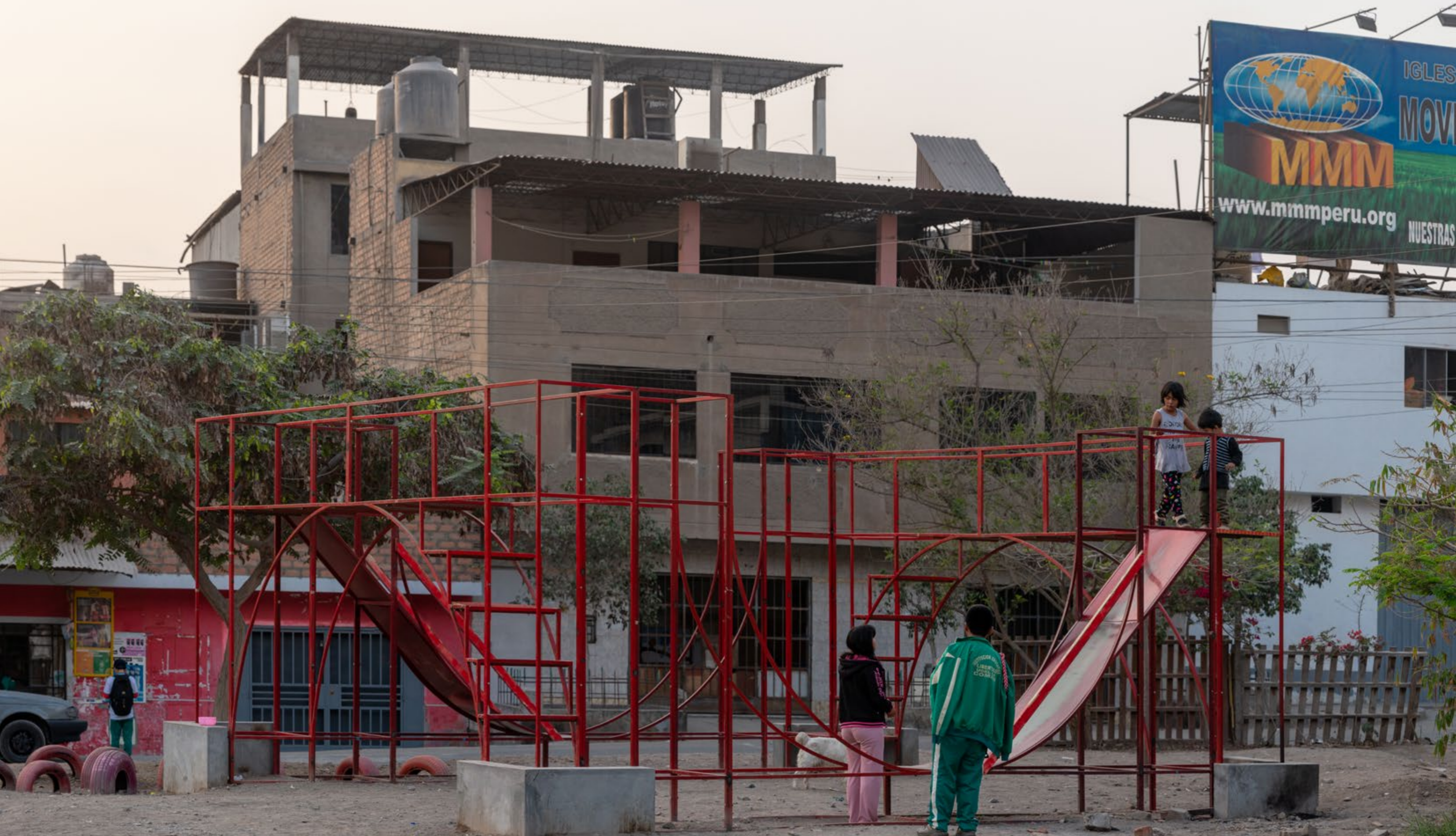
AULAS: Extramuros. Proyecto: La Escuela Libertad. Año Nuevo, Comas, Lima, Perú. Fotografía: Eleazar Cuadros. Cortesía: DIADIA Arquitectura.
